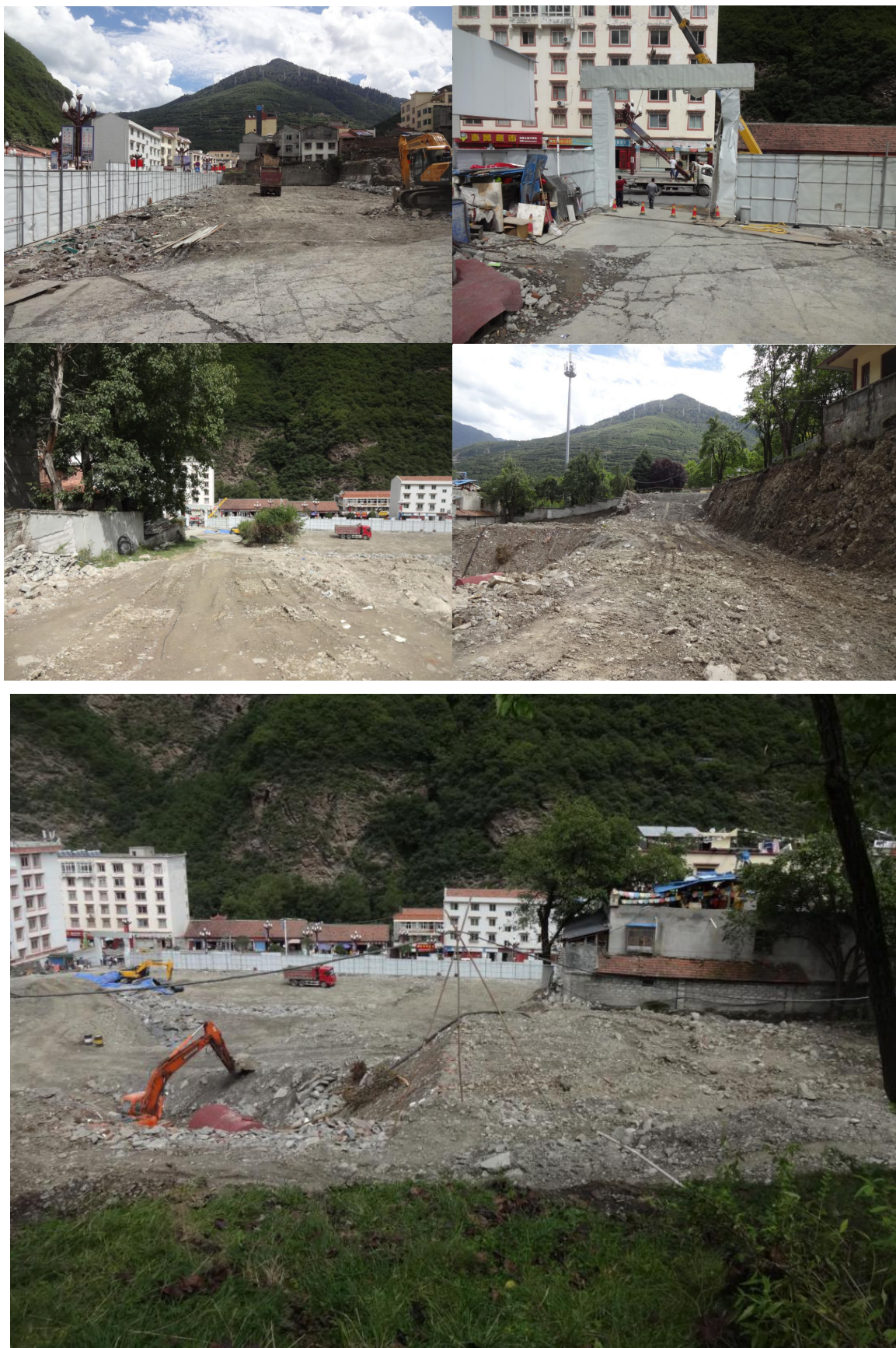
工程区施工场地现状
