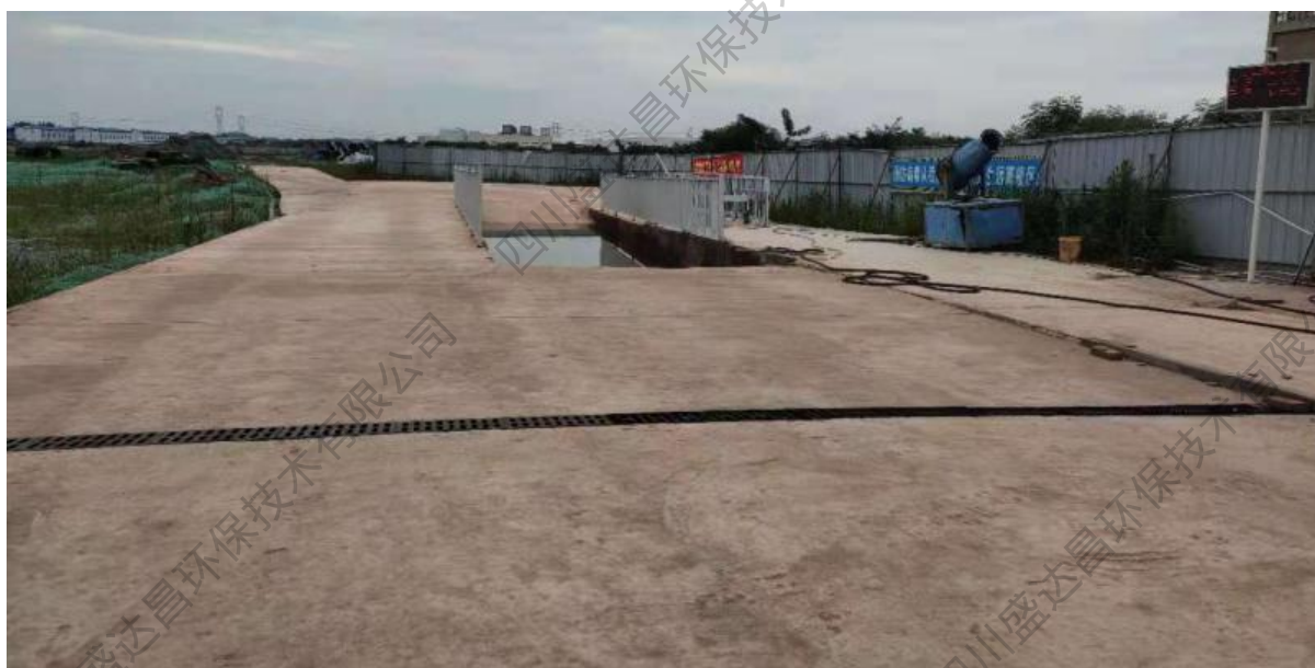
图 1.1-1 硬化区域及布设措施现状
