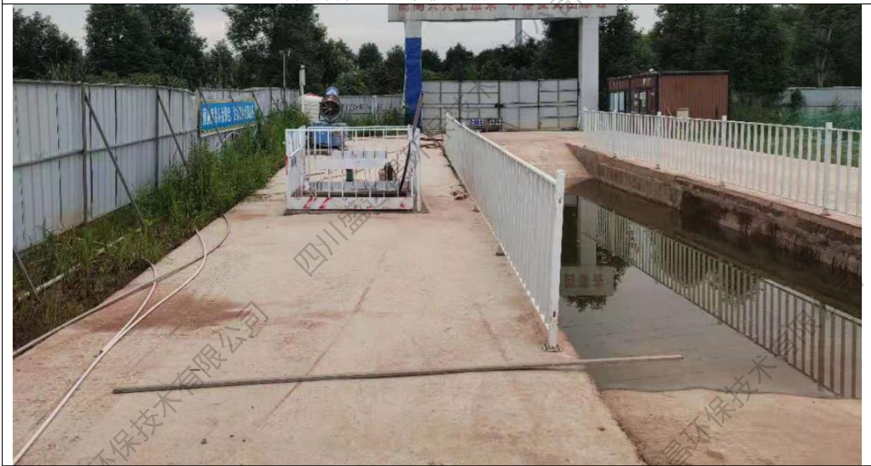
图4 洗车槽及沉砂池措施布设现状
