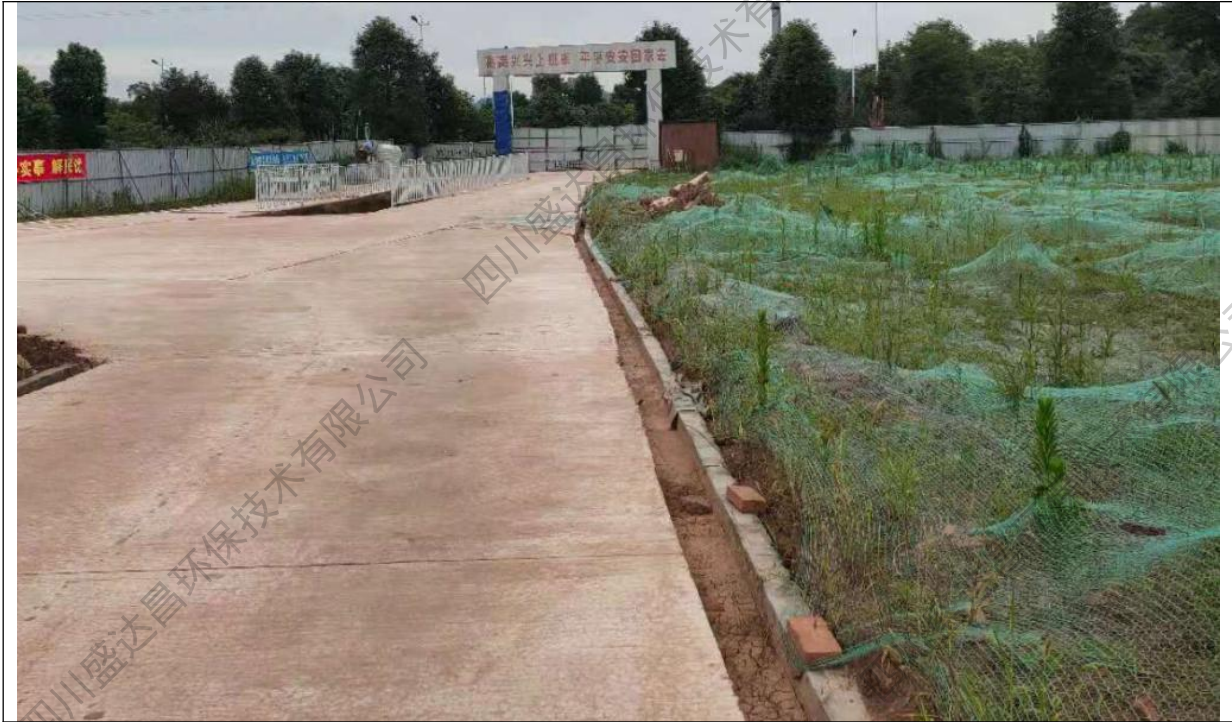
图3 道路硬化、临时排水沟及密目网实施现状
