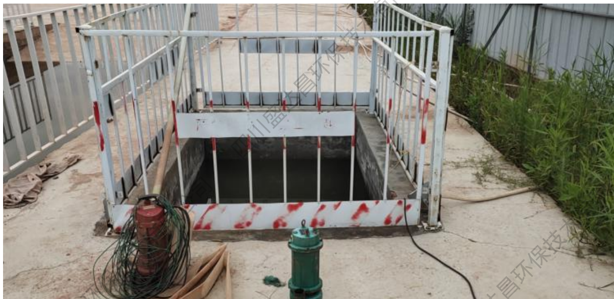
图 1.1-3 沉砂池措施现状
