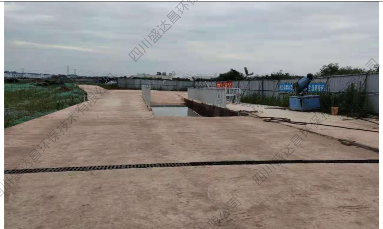
图2 场地出入口位置处洗车槽及截水沟措施现状
