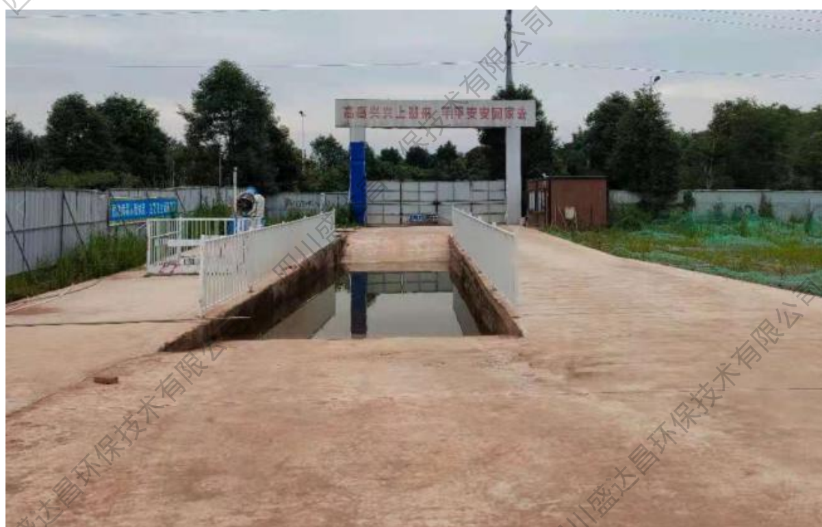
图 1.1-2 洗车槽措施现状
