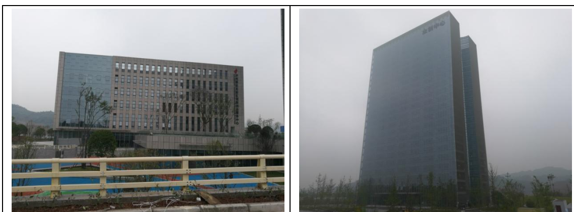
图 4-4 建构筑物工程区现状
