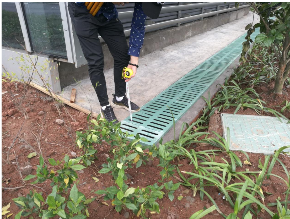
图 2-2 排水沟措施调查
