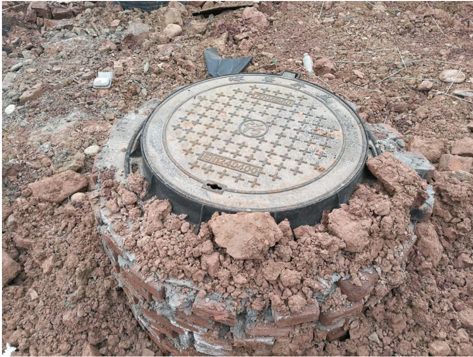
图 5-1 项目 A 区公建部分预处理池现状
