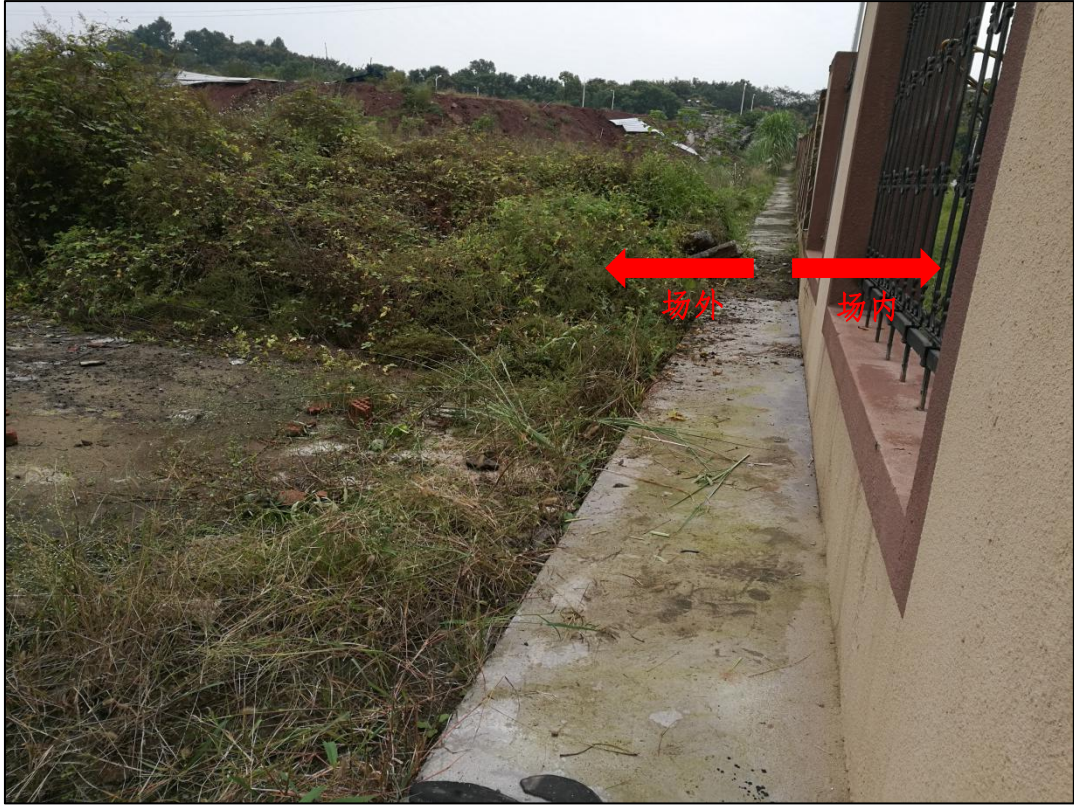
图 9 项目场界盖板排水沟现状
