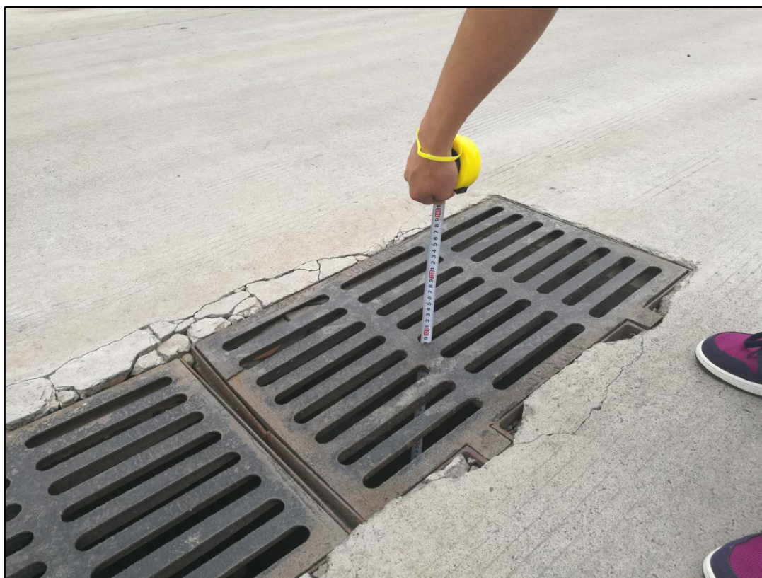
图 6 项目雨水篦现状照片
