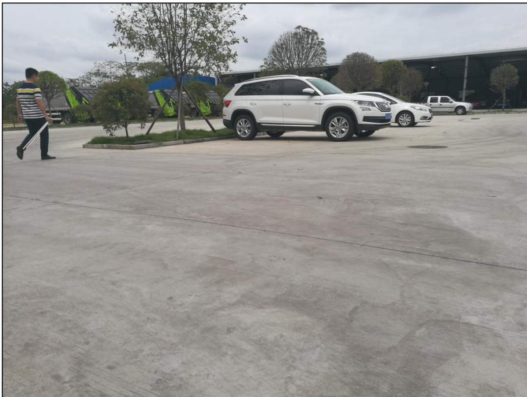
图 5 项目道路及停车场区现场照片
