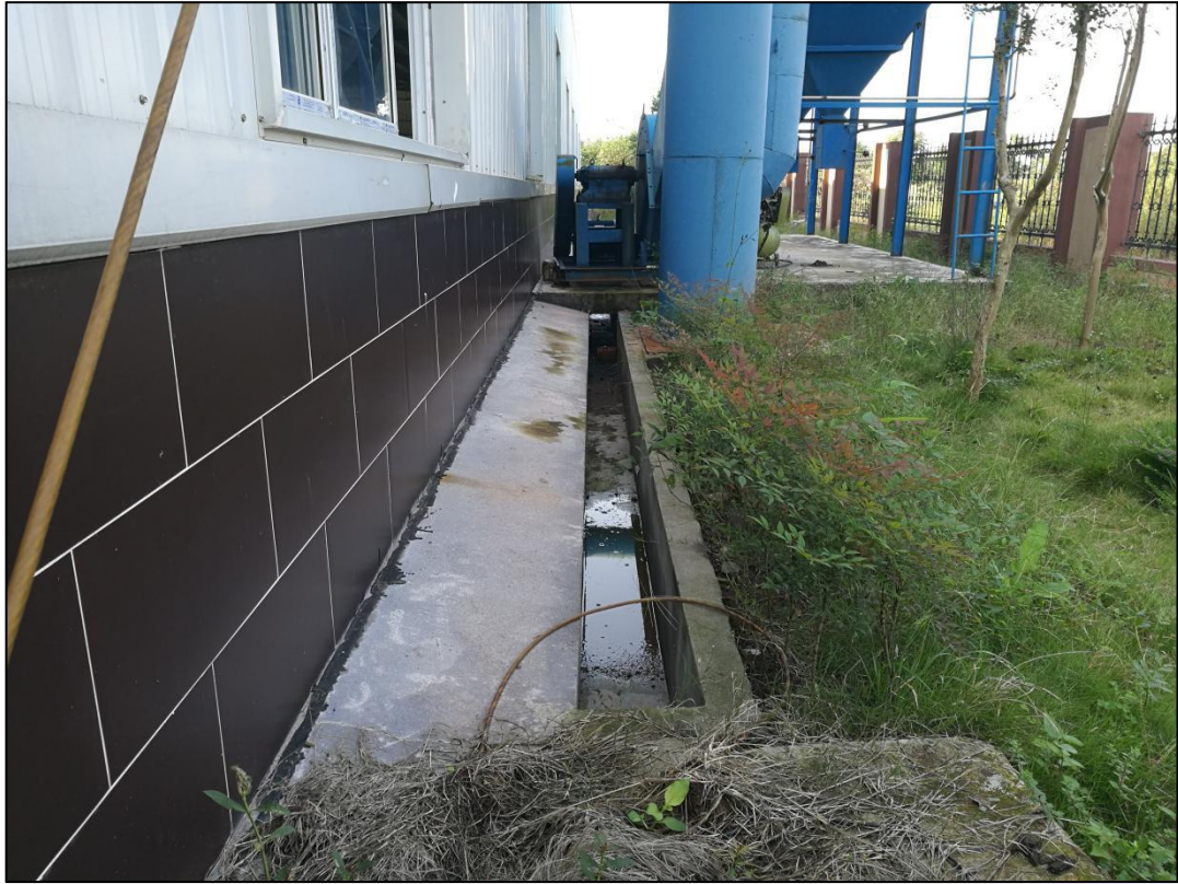
图 7 项目作业区排水沟现状
