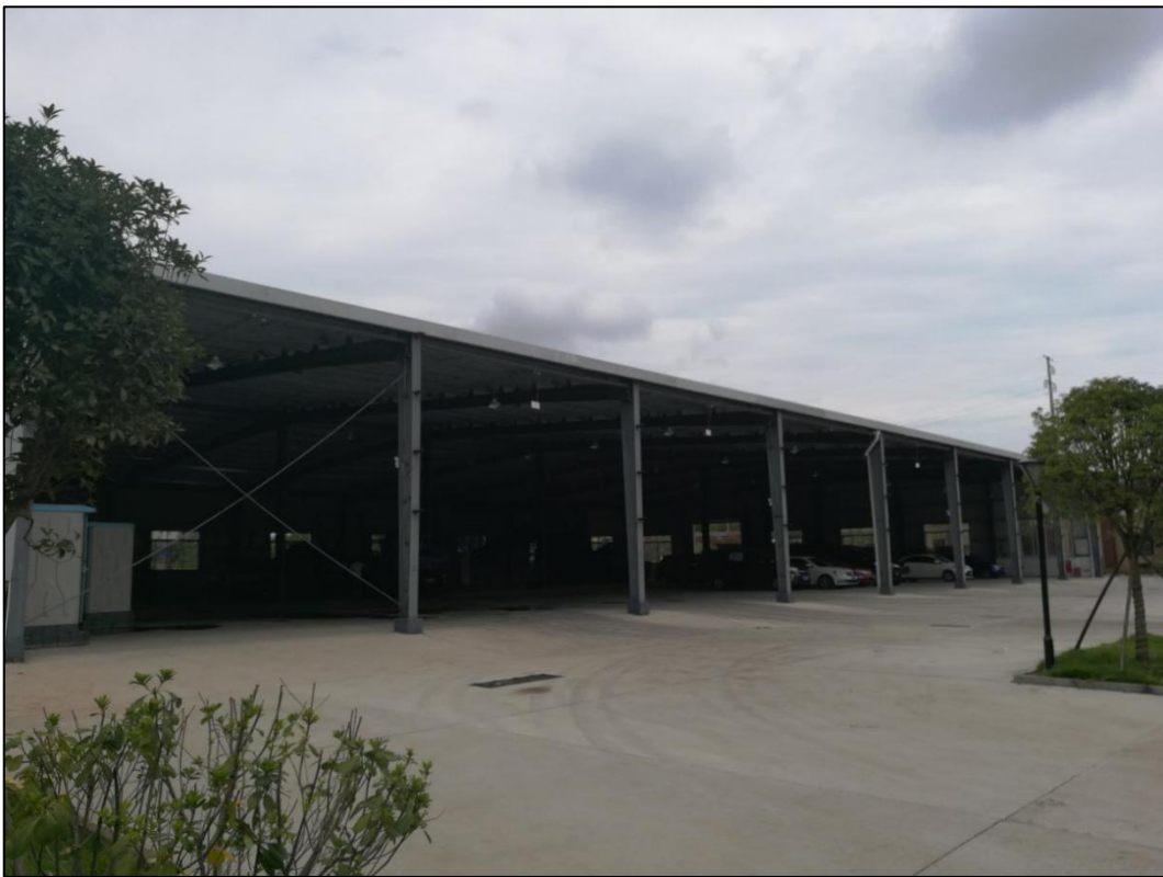
图 2 项目作业区大件垃圾破碎厂房现场照片
