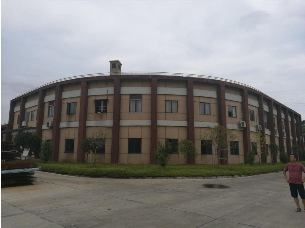
图 1 项目作业区垃圾中转房现场照片
