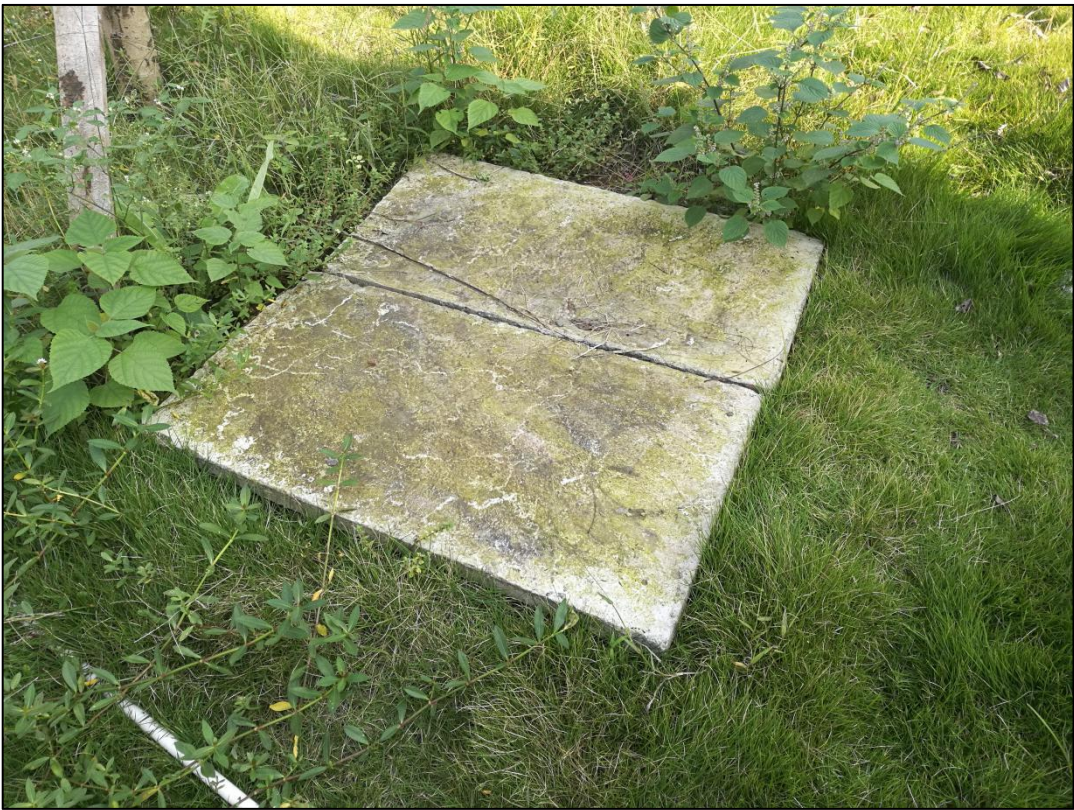
图 10 项目沉沙池现状
