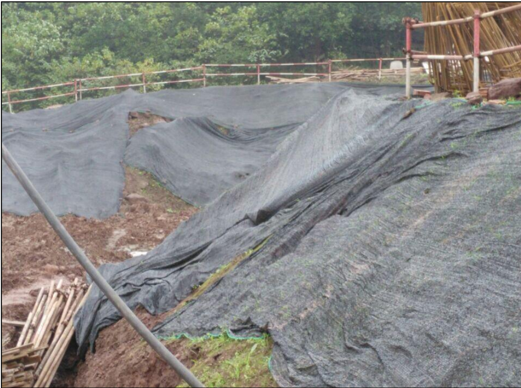
图 12 项目施工期塑料布遮盖照片
