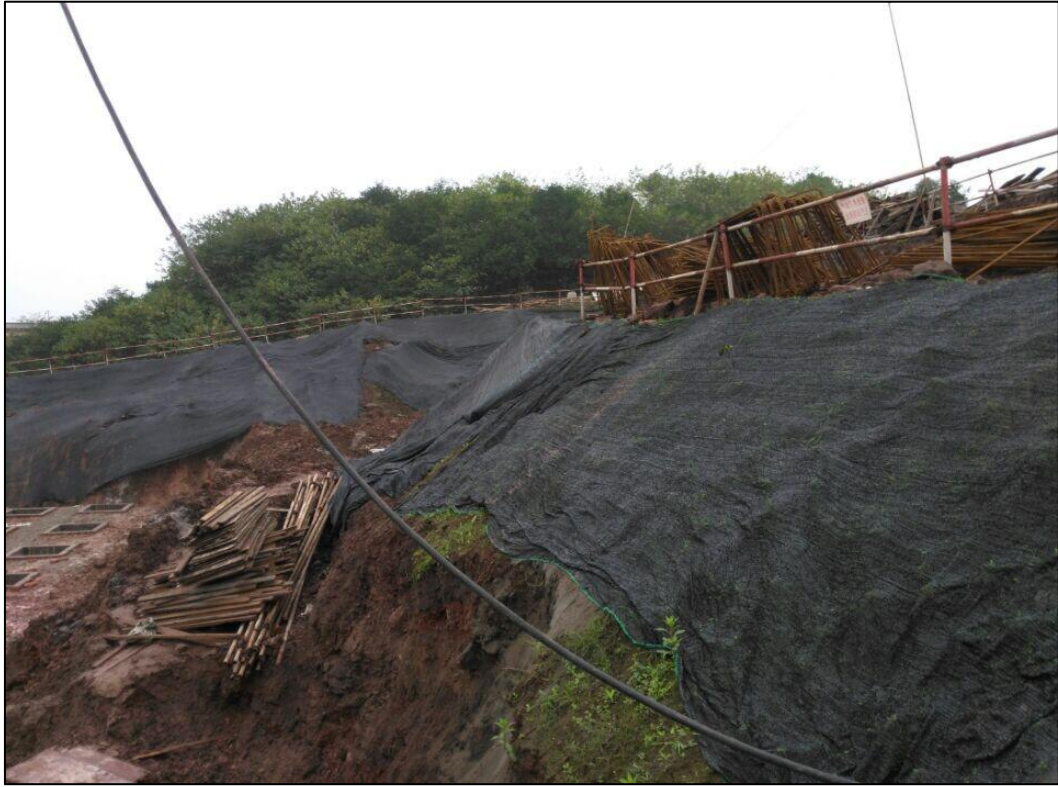
图 13 项目施工期边坡照片
