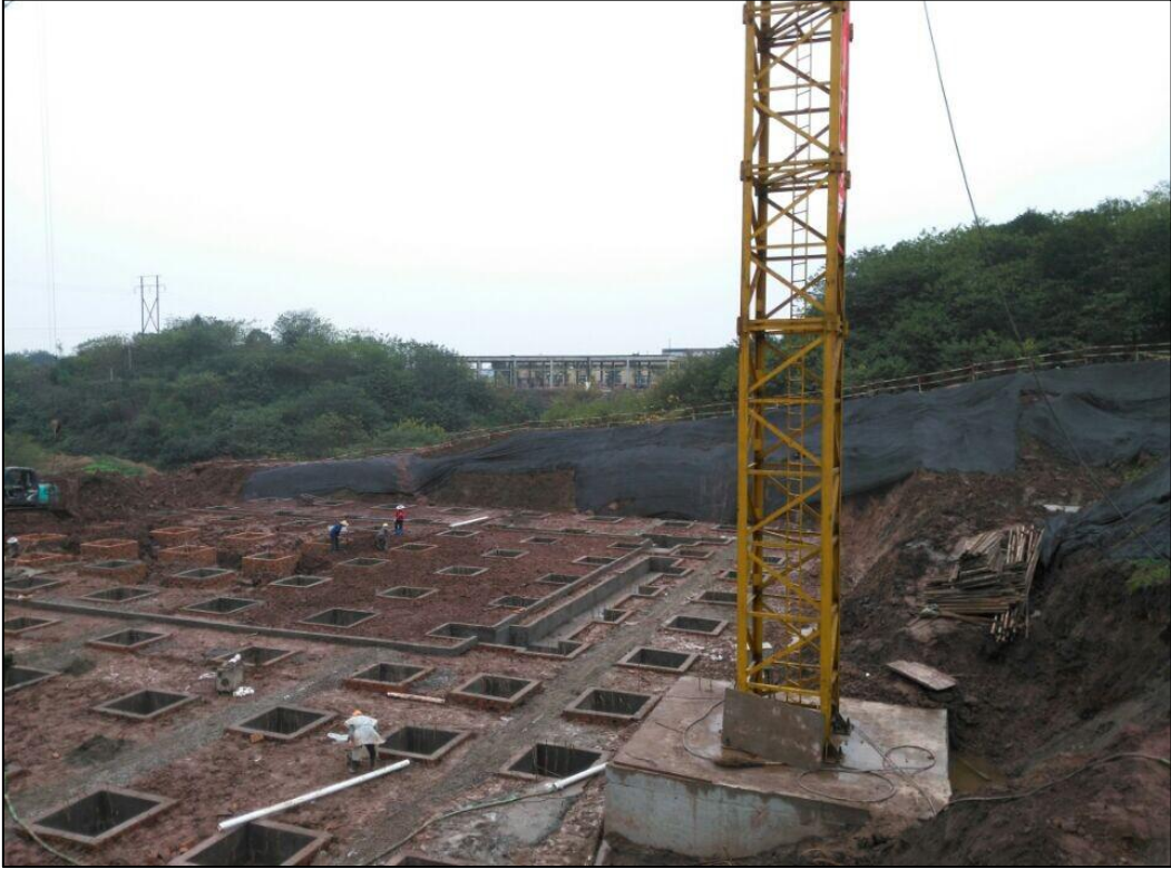
图 11 项目施工期地基开挖照片
