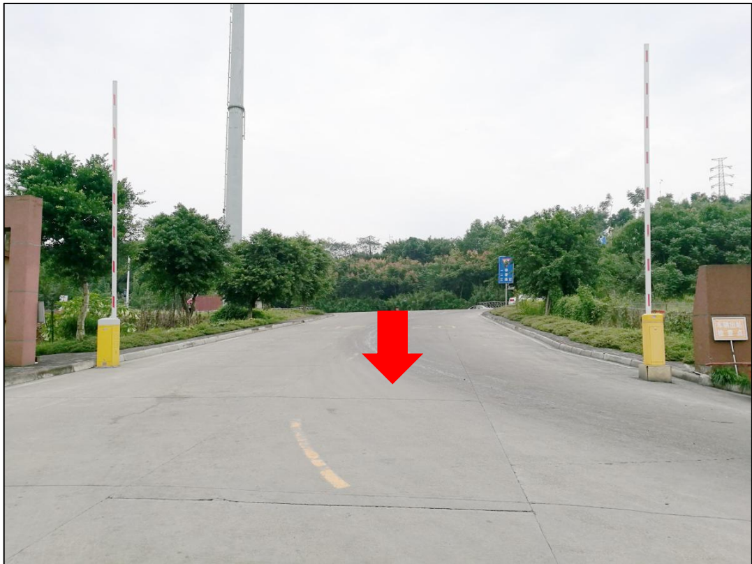
图 8 项目进场道路区现状
