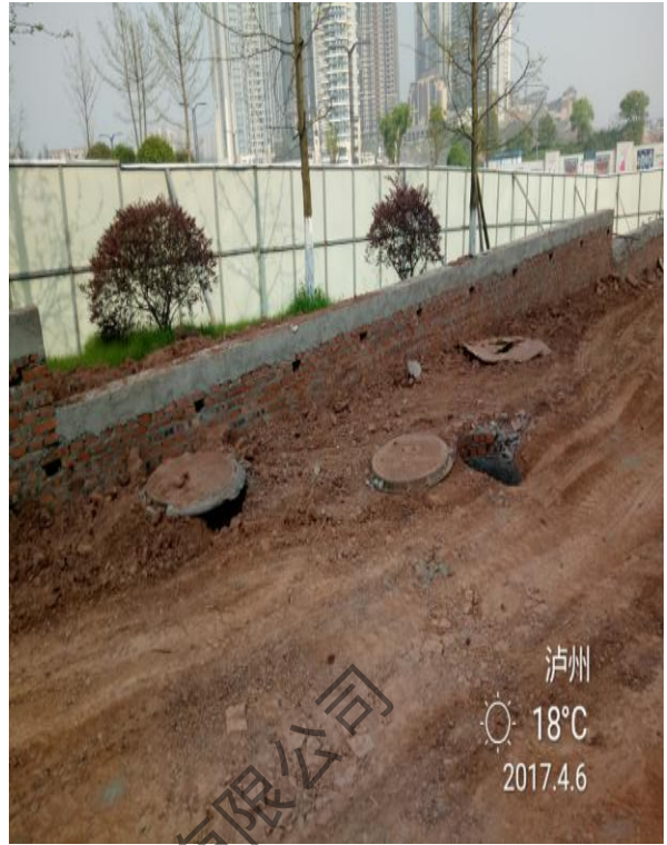
施工区域两侧打围 2
