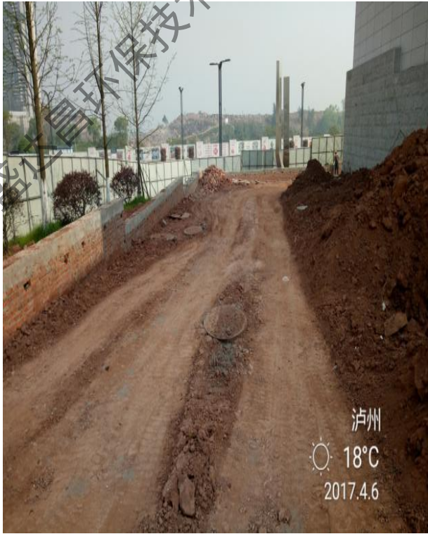
施工区域两侧打围 1
