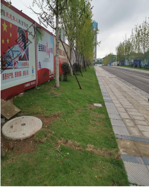
项目绿化工程、雨水工程及电力井
