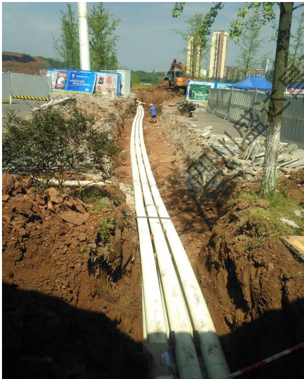
施工期管网铺设现场
