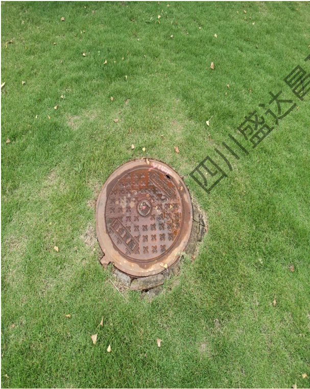
项目雨水井盖
