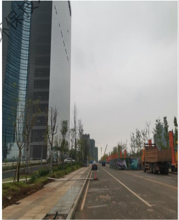
项目照明工程（目前建设照明管沟，未安装路灯）
