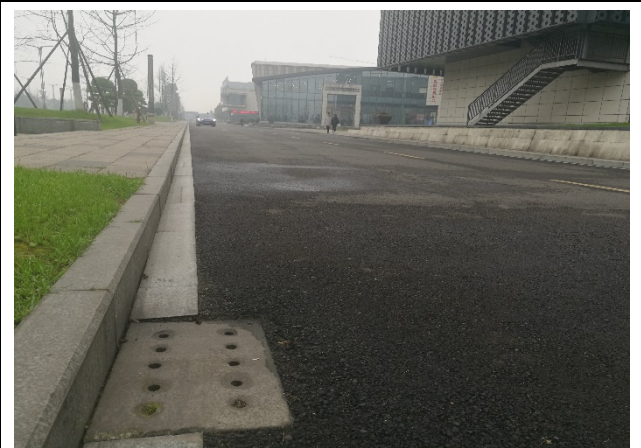
道路两侧雨篦子
