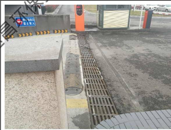
地下车库出入口排水沟
