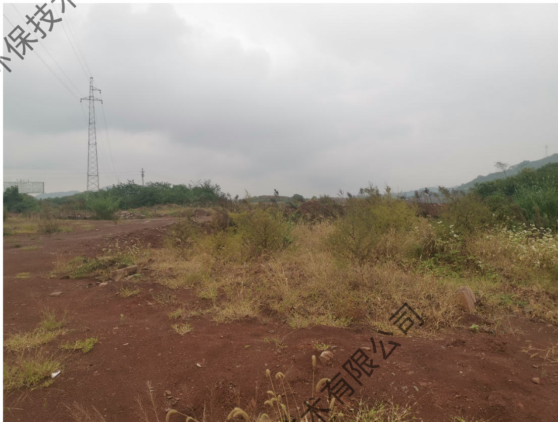
图 3.2-2 高新区园区七通一平（场平五期）工程现状
