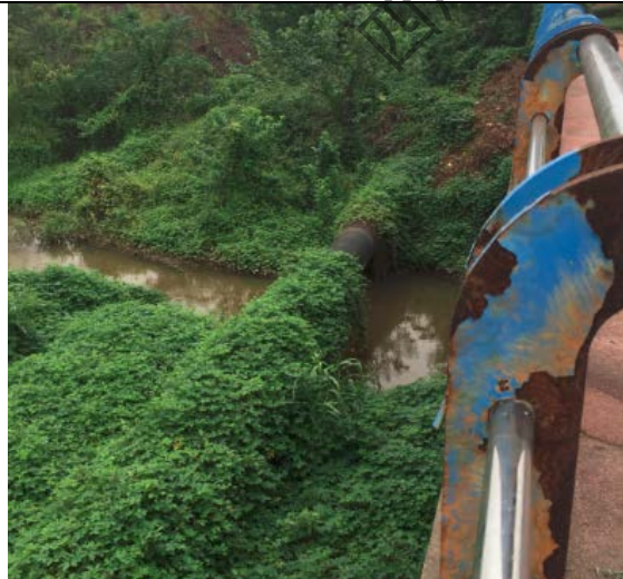
图 3 管道穿越溪沟处现状（天府中学对面）
