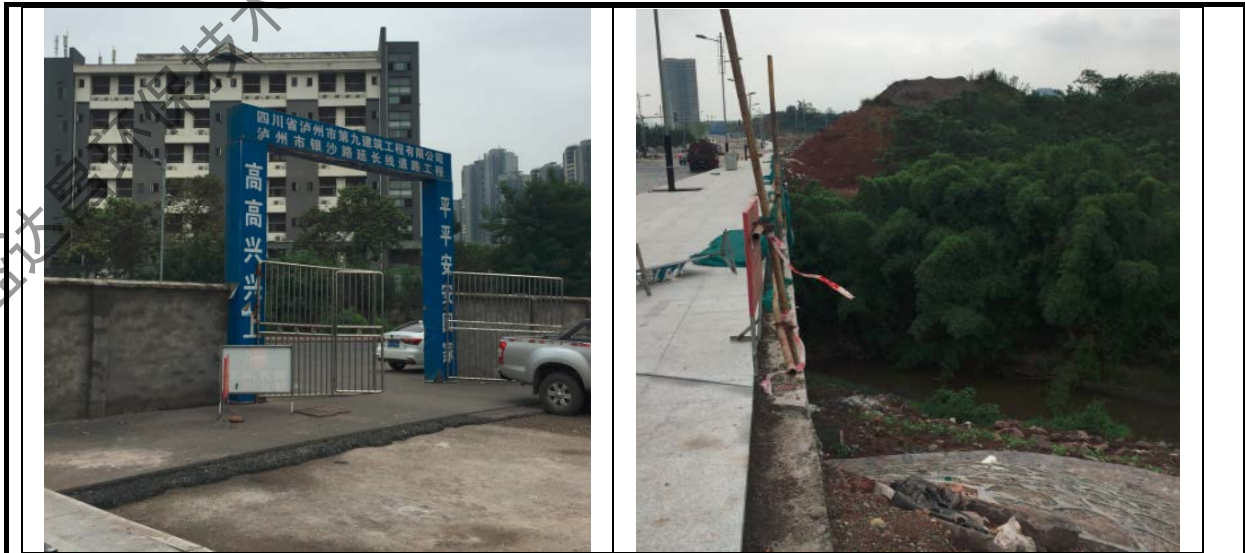
图 5 银沙路延长线工程段-渔子溪大桥处现状
