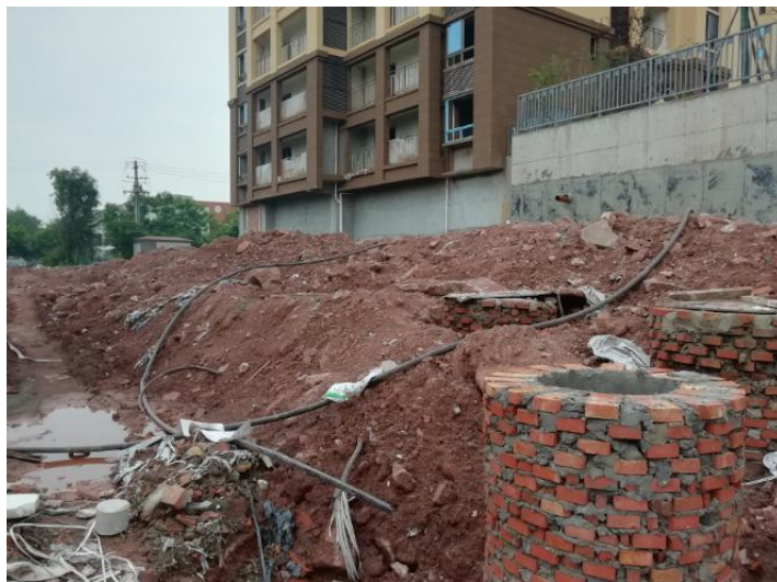
图 4-3 项目预处理池井盖现状图
