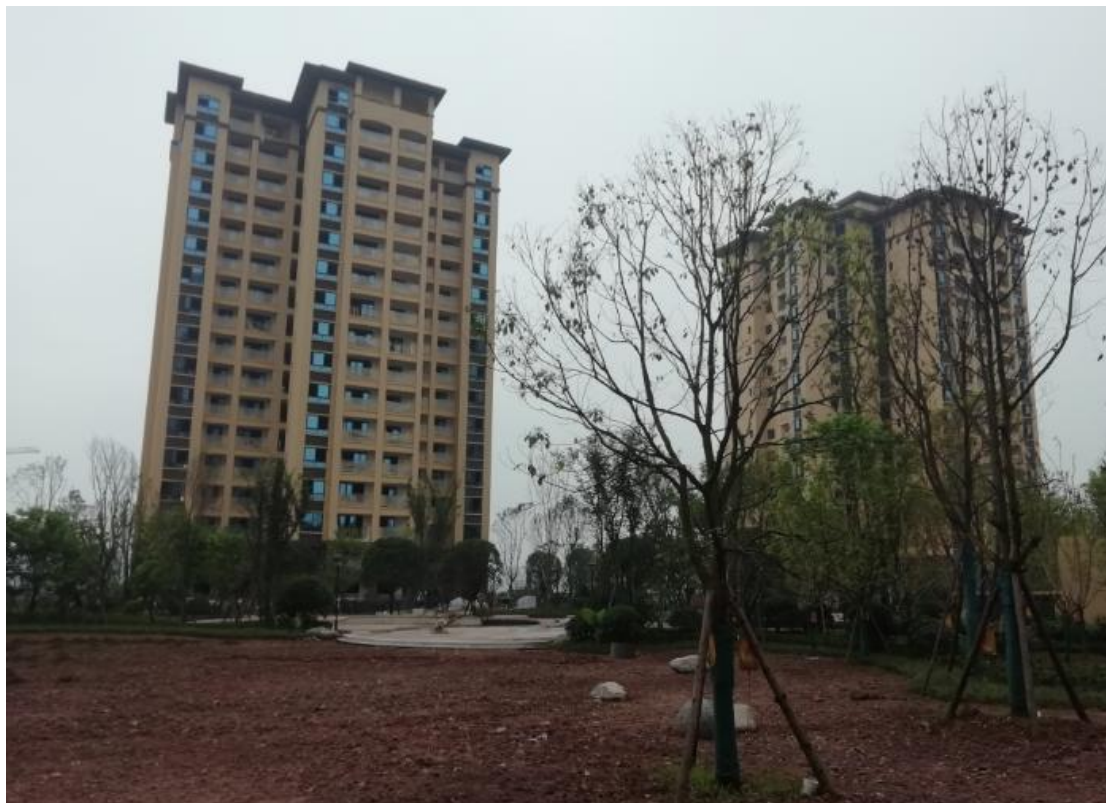
图 4-1 项目主体工程现状
