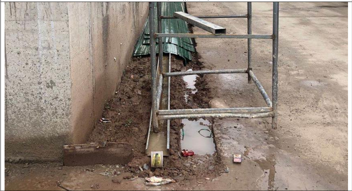
图 4 排水沟措施现状
