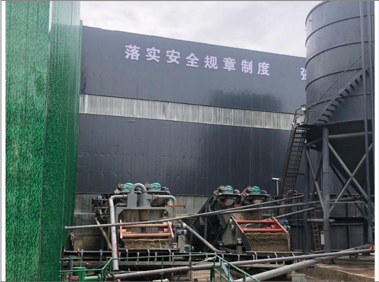
图 1 主体工程建设现状
