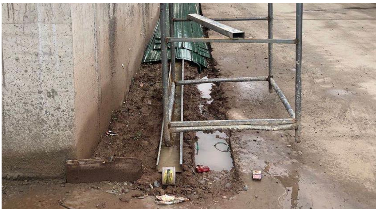
图 1.1-2 主体实施的排水沟措施现状
