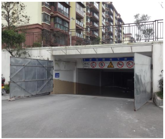
地下室出入口
